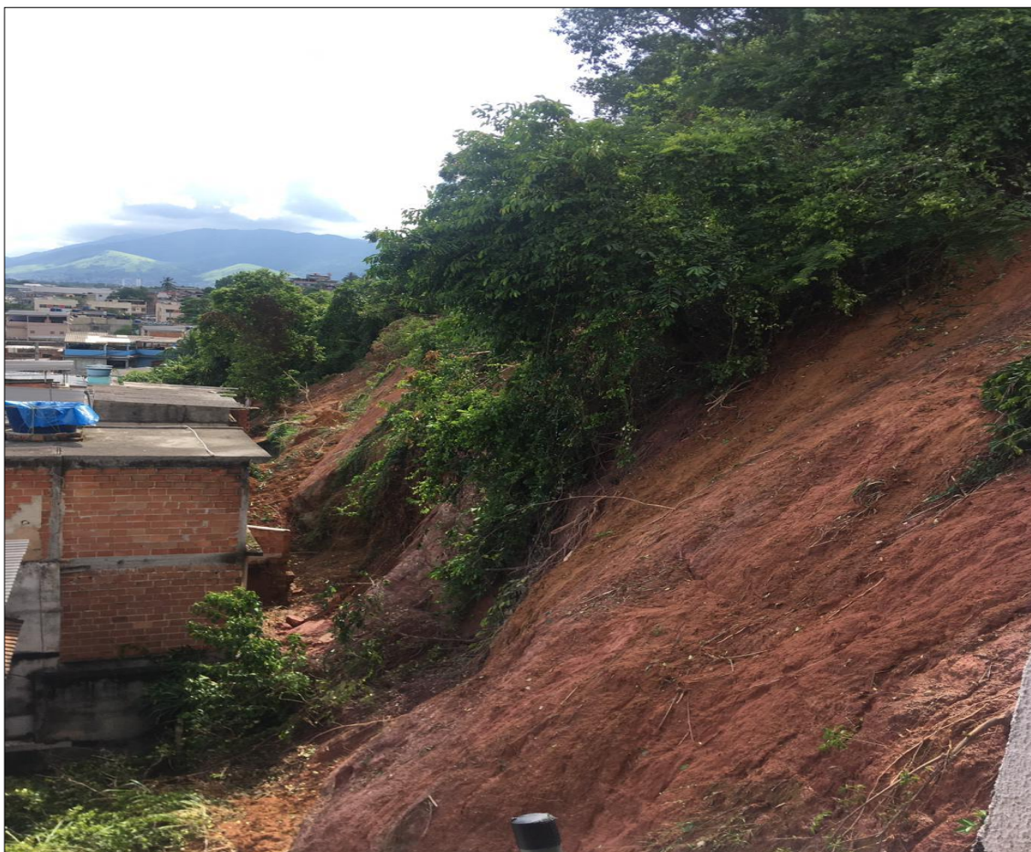
Figura 2 – Talude de aproximadamente 15 m de inclinação subvertical com deslizamentos planares que atingiram os fundos dos imóveis da Rua Chumbo, no Bairro Coelho da Rocha
