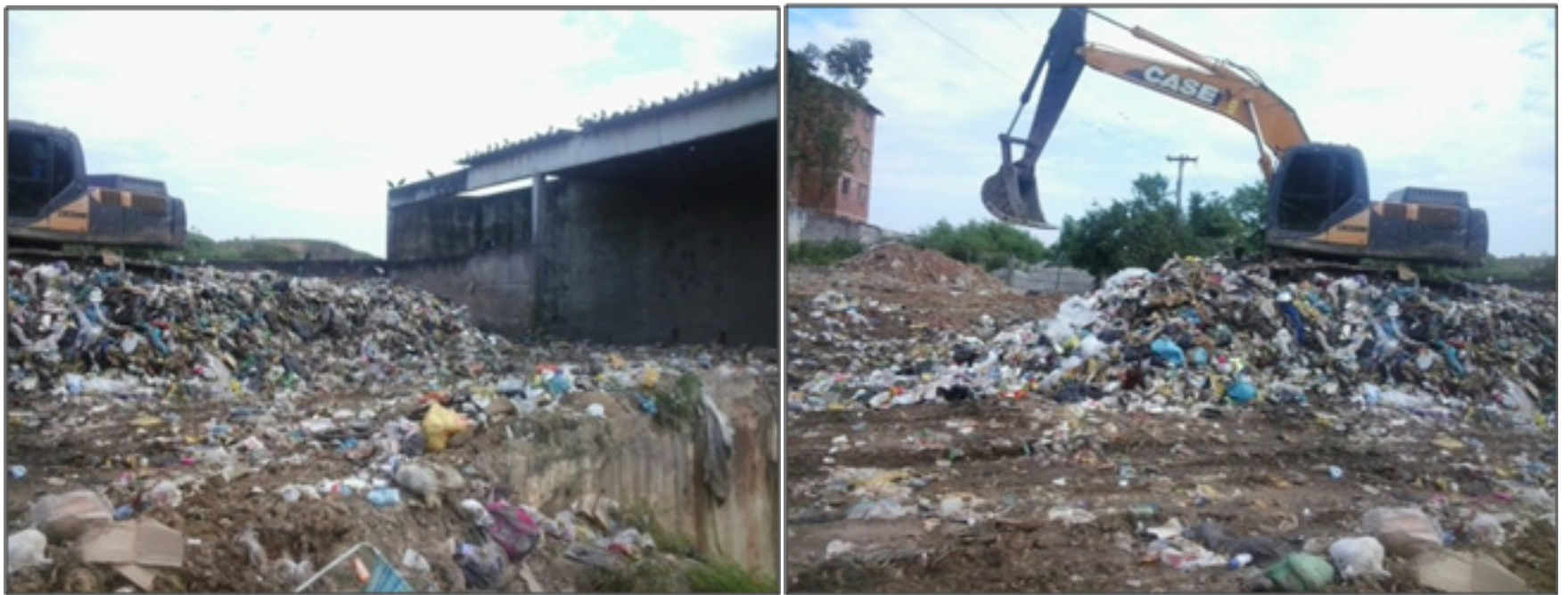
Foto 5.12-1 e 5.12-2: Vista Geral da Estação de Transferência de Lixo – Bairro Venda Velha.
