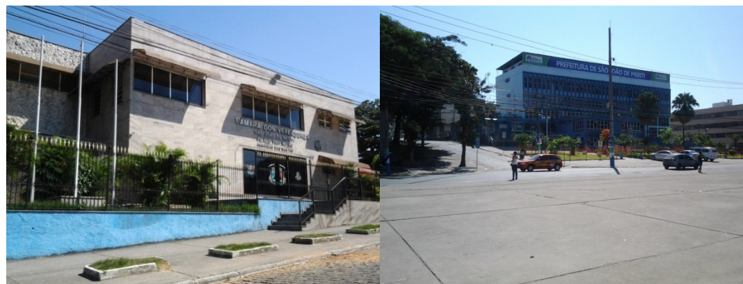
Fotos 3.2-2 e 3.2-3: Vista Geral do prédio da Prefeitura e da Câmara Municipal de São João de Meriti (maio/2013)
