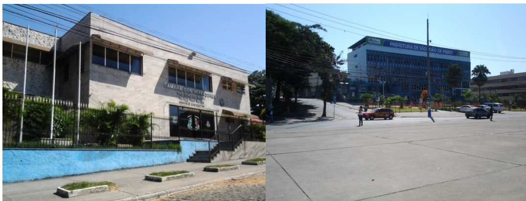
Fotos 3.2-2 e 3.2-3: Vista Geral do prédio da Prefeitura e da Câmara Municipal de São João de Meriti (maio/2013)
